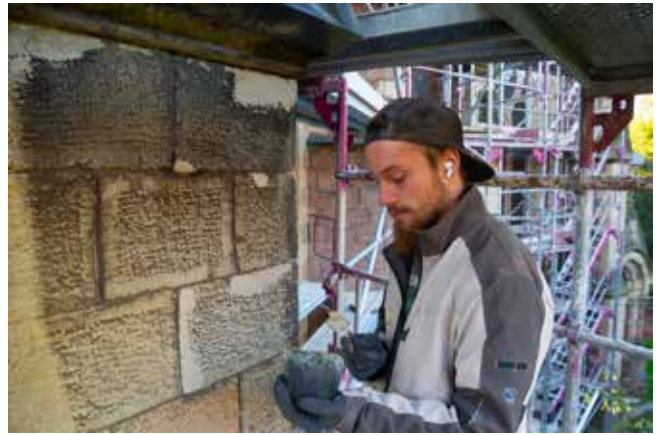
Tom Henke von der Firma Vogt Naturstein und Denkmalpflege bei der Fassadensanierung 2022.
