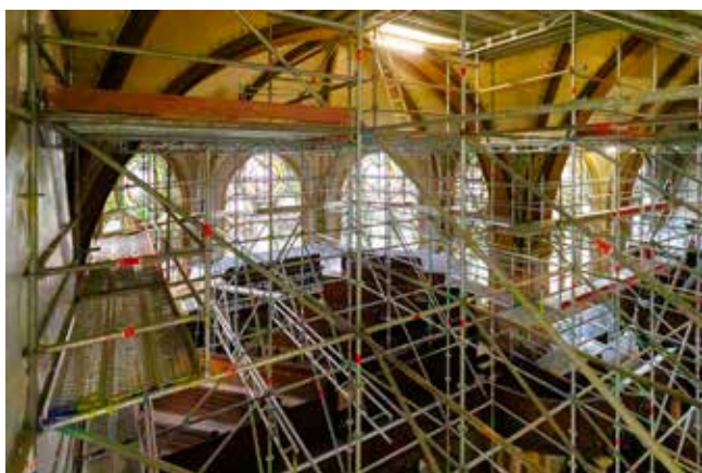
Das Kirchenschiff ist 2020 vollständig eingerüstet für die Sanierung der Gewölbe.
