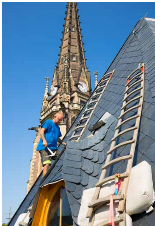
Die Wiederherstellung der Dachgauben und Neueindeckung des Kirchendaches 2019.
