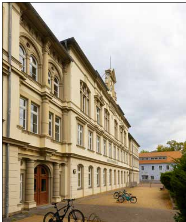
Die renovierte Johannesschule, im Hintergrund der neue Schulhort.
